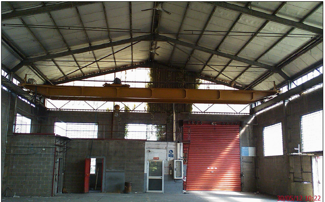
FOTO INTERNA CAPANNONE OGGETTO DI DEMOLIZIONE
