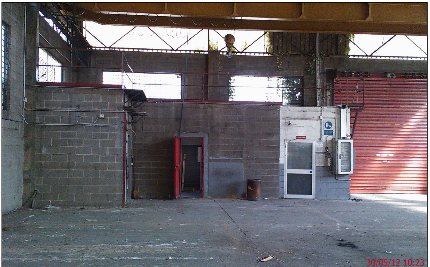
FOTO INTERNA CAPANNONE OGGETTO DI DEMOLIZIONE
