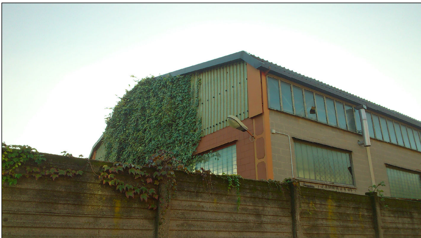
FOTO 9 - CAPANNONE OGGETTO DI DEMOLIZIONE
