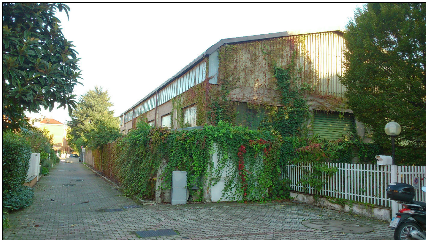
FOTO 10 - CAPANNONE OGGETTO DI DEMOLIZIONE
